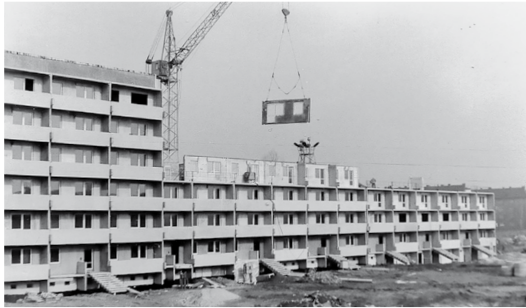
Die Lommatzcher Straße damals und heute: Was im März 1985 als Baustelle begann ...
